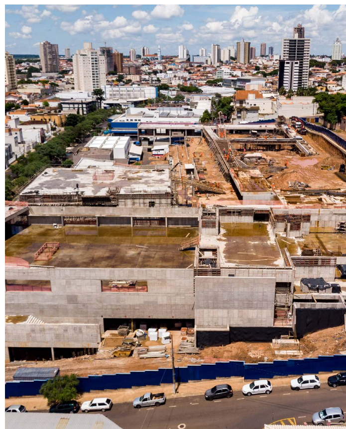
foto: Pedro Abude | Obras Sesc Franca
